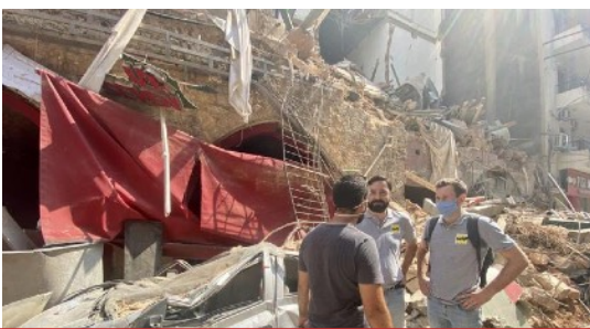
Kayu Orellana (M.) hilft in Beirut auch beim Wiederaufbau von Wohnraum. Help – Hilfe zur Selbsthilfe/S. Maier
